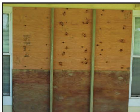
Figura 4-19. Para las ventanas más grandes, como esta puerta de vidrio corrediza, se colocan dos tirantes de 2 por 4 del lado de afuera y se orientan con el extremo angosto contra la madera terciada. La madera terciada se sujeta a los tirantes de 2 por 4 mediante tornillos de fijación.
