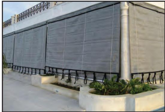
**Figura 4-16. Paravientos de tela de tejido de esterilla de polietileno desplegada en el borde de un patio, que encierra toda el área.**
