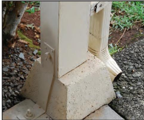
**Ejemplos de reequipamiento. Aquí una banda de metal conecta el poste vertical a los cimientos, completando así la conexión estructural continua desde el techo hasta los cimientos.**
