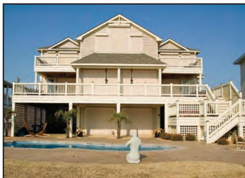
**Figura 4-8. Hogar costero protegido por persianas de enrollar en todas las ventanas y puertas. La persiana se mantiene en su lugar mediante rieles verticales y puede operarse manualmente o con un motor eléctrico integrado.**
