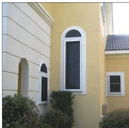
**Figura 4-14. Pantallas instaladas de acero inoxidable resistentes a impactos protegen varias ventanas de una vivienda costera. Este sistema no requiere despliegue y proporciona sombra.**
