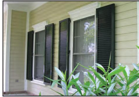
**Figura 4-11.** Las persianas de tipo colonial hechas de componentes duraderos de aluminio extruido añaden una apariencia tradicional al hogar y protegen las aberturas de ventanas.
