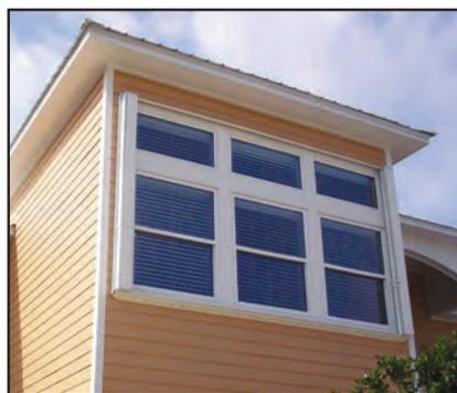
**Figura 4-9. Persianas de acordeón (ilustradas en posición abierta) instaladas en un grupo grande de ventanas de un hogar ubicado en la zona costera. Las persianas se instalaron de modo tal que pueden operarse desde el interior del hogar.**
