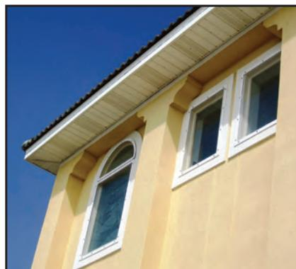
**Figura 4-15. Paneles de policarbonato plano de alto impacto instalados directamente sobre las ventanas de un hogar costero. Esta cobertura de ventanas proporciona una excelente protección contra la tormenta con un impacto estético mínimo.**
