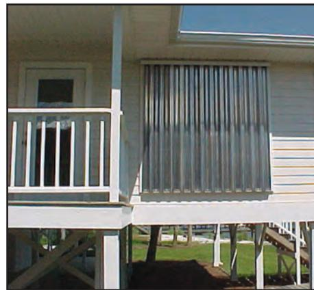
**Figura 4-13.** Estos paneles anti tormenta de aluminio de calibre 0.050 ofrecen una protección económica contra las tormentas. En este ejemplo, los paneles se insertan en una guía sobre la ventana y se sujetan a una guía inferior mediante tuercas de mariposa.
